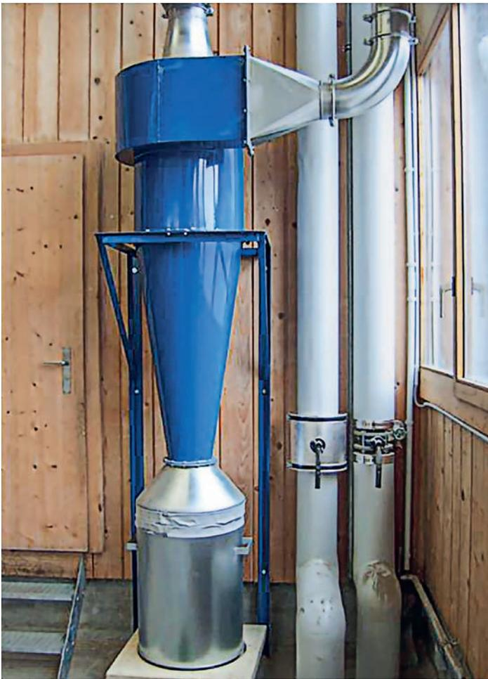
Ein recht kleiner Zyklon sorgt für die Trennung unerwünschter Stäube beim Zuschnitt an einer Striebig.
